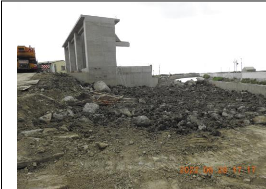
水門施工現況 (拍攝日期 111 年 6 月 28 日)
