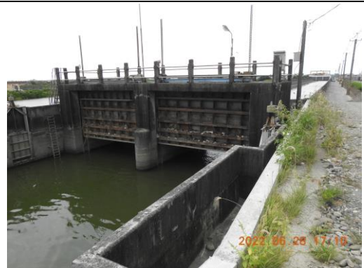
工區上游灌溉取水閘門 (拍攝日期 111 年 6 月 28 日)
