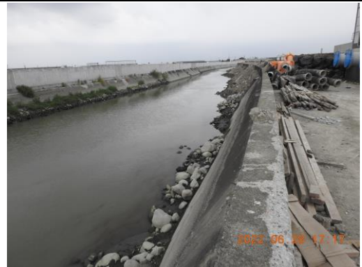
鴨母寮排水渠道現況 (拍攝日期 111 年 6 月 28 日)
