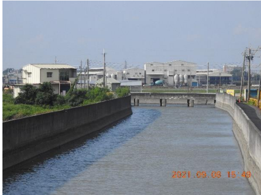
渠道現況貴舍下游出口 (拍攝日期 110.09.08)
