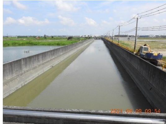
渠道現況下游視向 (拍攝日期 110.09.09)
