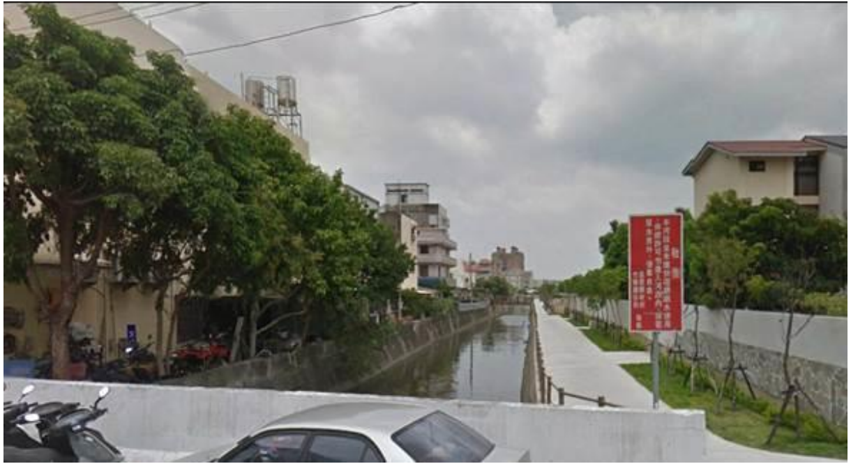
建國路與射流溝位置現況
