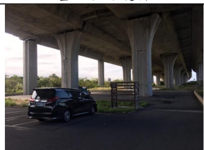
國道3橋墩下目前作為停車場使用
