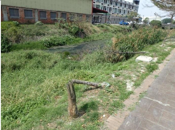
部分河道旁有景觀樹木乾枯未整理
