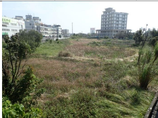
水質淨化改善工程計畫範圍現況
