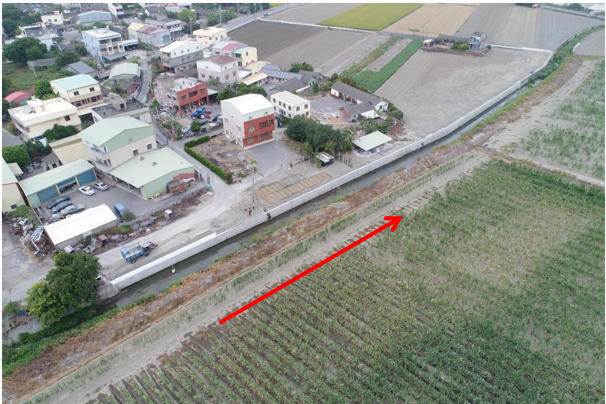
圖 9 溝頭排水(香田里外蘆竹塘段)應急工程之棲地環境空拍圖(109/10/21)
