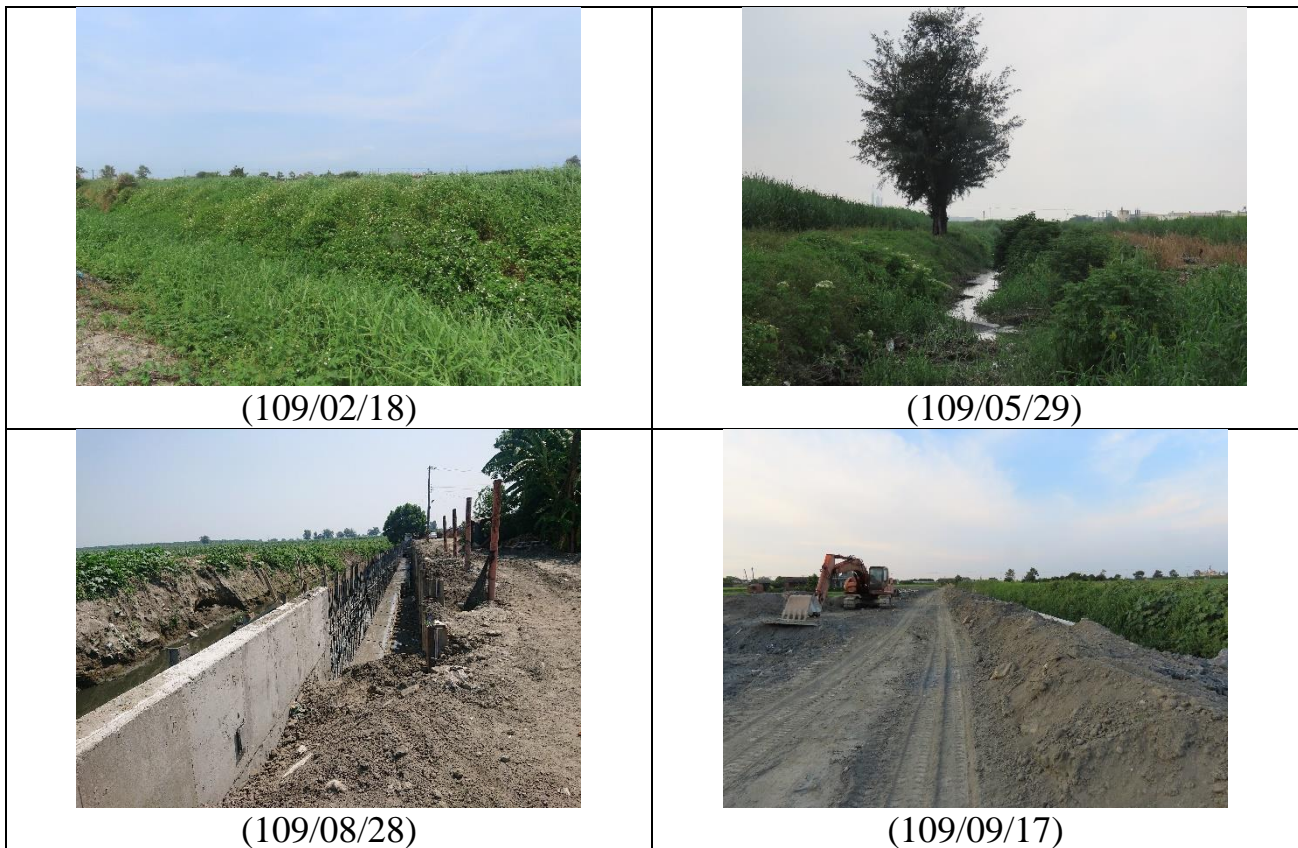
圖 4 溝頭排水快棲評估現況照片(施工中)
