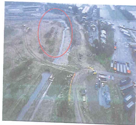
[施工階段](照片)
