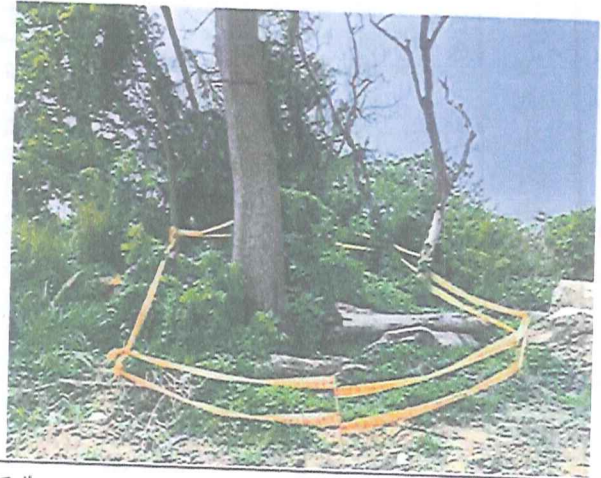
[施工階段](照片)
