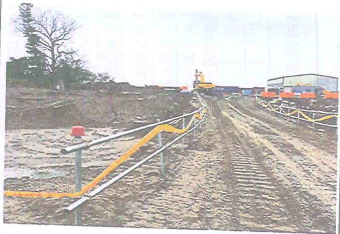
[施工階段](照片)
