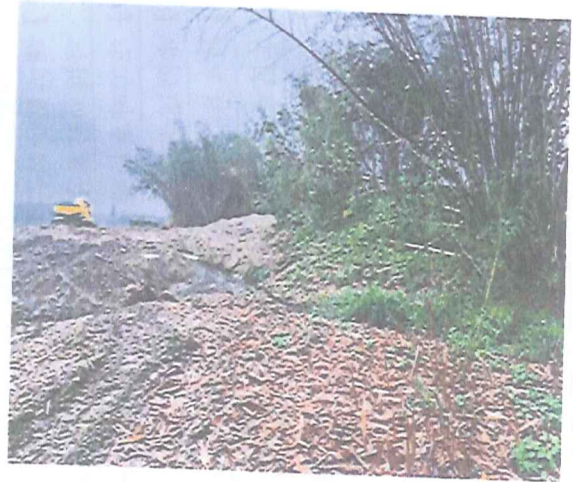
[施工階段](照片)
