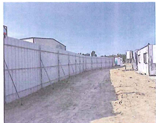
[施工階段](照片)
