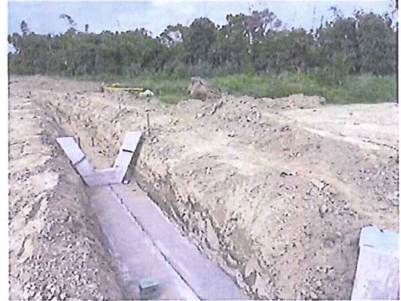
[施工階段](照片)
