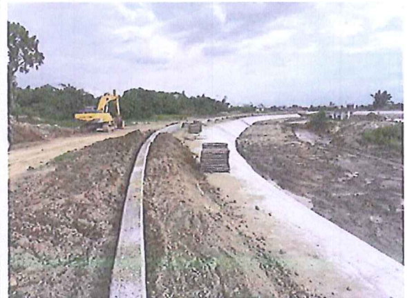
[施工階段](照片)
