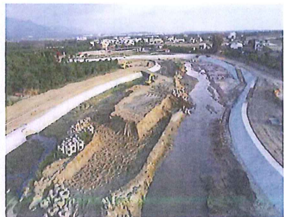
[施工階段](照片)
