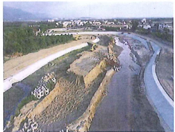
[施工階段](照片)
