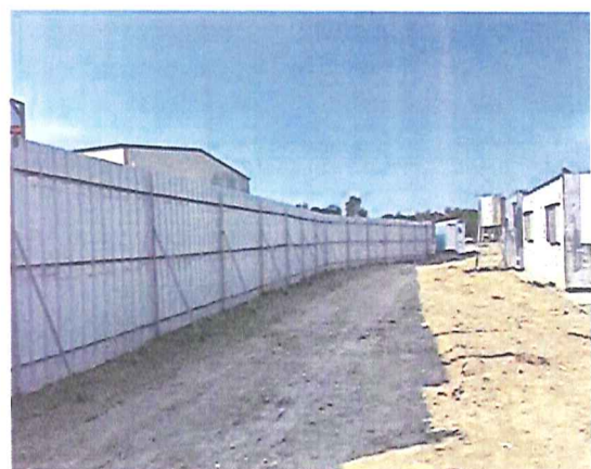
[施工階段](照片)
