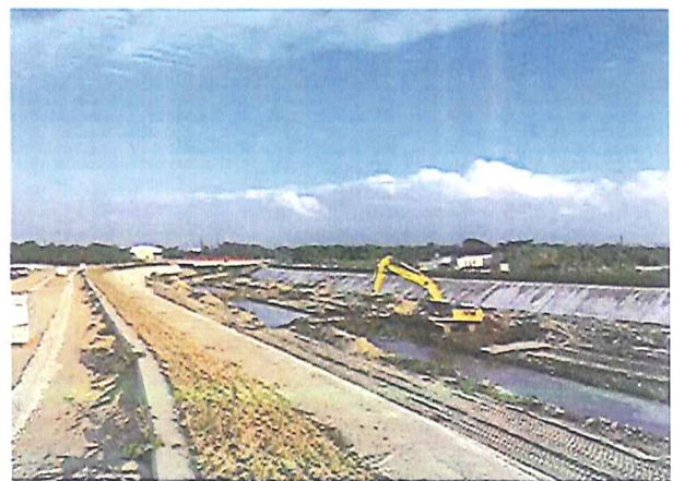
[施工階段](照片)
