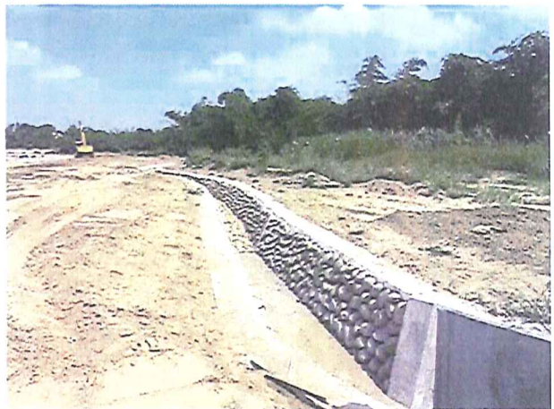
[施工階段](照片)
