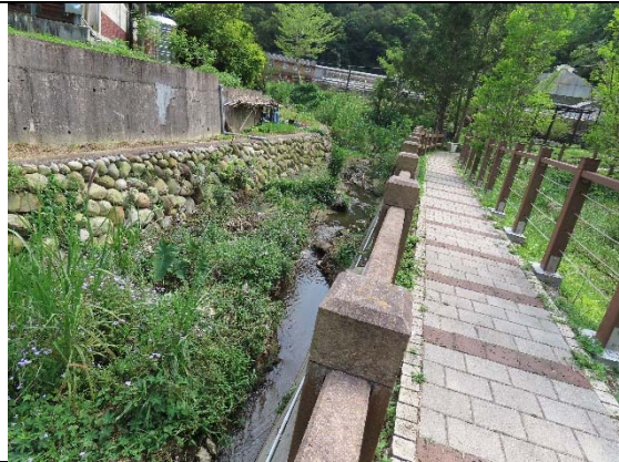
勝興車站西湖溪環境現況
