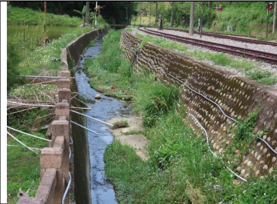
勝興車站西湖溪環境現況
