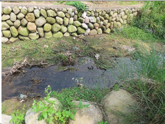
勝興車站西湖溪環境現況
