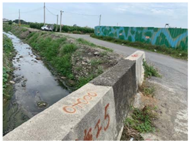
水岸及護坡照片
