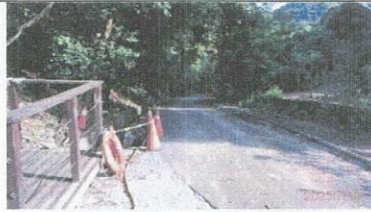
圖1：109.07.13 施工便道現況
