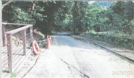
圖1：109.07.23 施工便道現況
