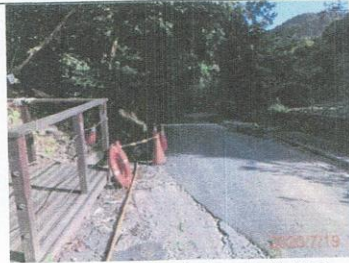
圖1：109.07.19 施工便道現況
