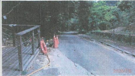
圖1：109.07.06 施工便道現況
