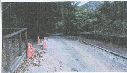
圖1：109.09.07 施工便道現況
