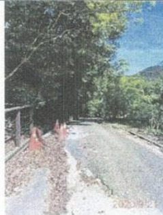
圖 1：109.09.21 施工便道現況
