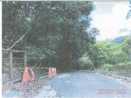
圖1：109.10.02 施工便道現況
