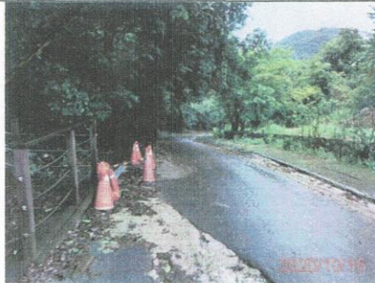
圖1：109.10.16 施工便道現況
