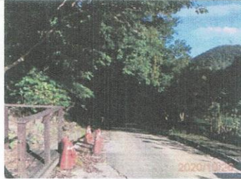
圖1：109.10.26 施工便道現況
