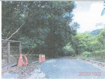
圖1：109.10.02 施工便道現況
