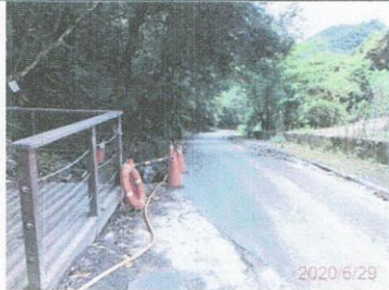
圖1：109.06.29 施工便道現況
