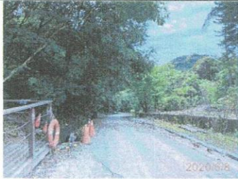
圖1：109.06.08 施工便道現況
