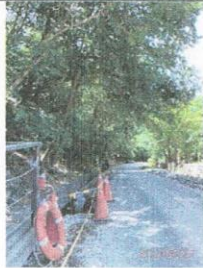
圖1：109.06.21 施工便道現況
