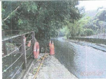
圖1：109.05.29 施工便道現況
