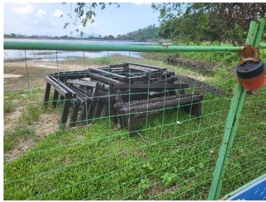
工程材料集中堆放
