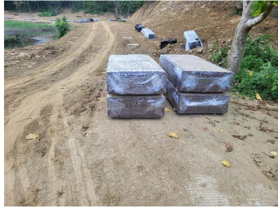
工程材料集中堆放
