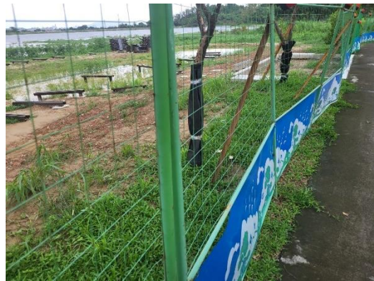
設置護欄預防動物進入
