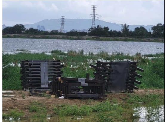
工程材料集中堆放
