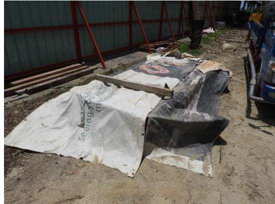
施工材料集中堆放
