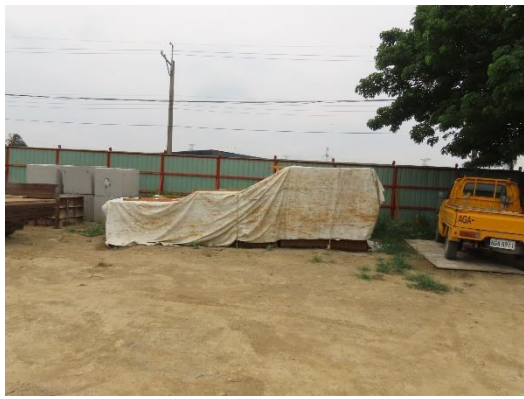
工程材料集中堆放
