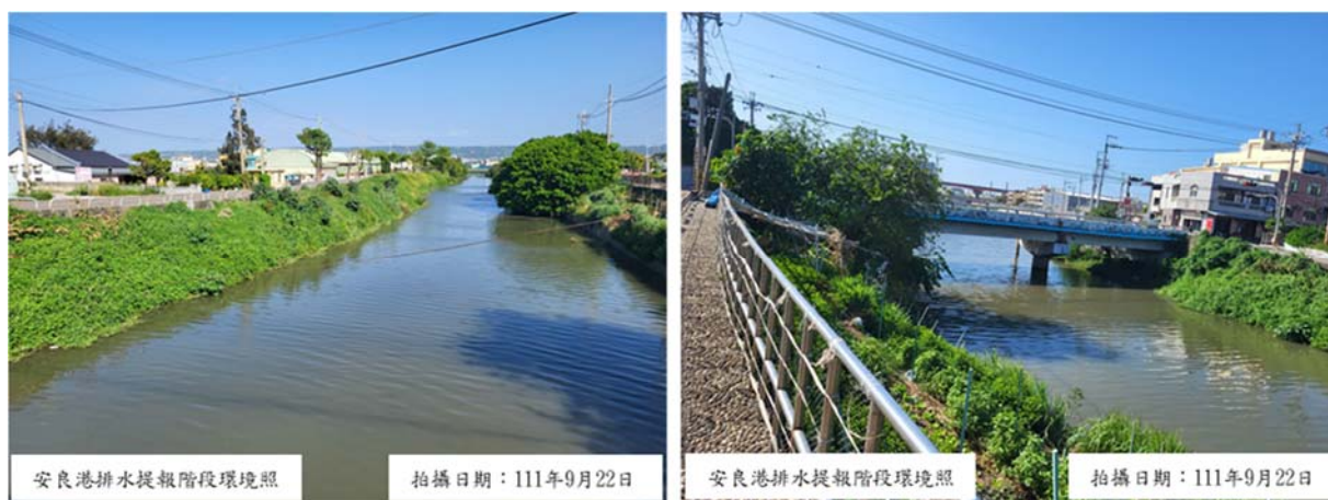
圖 1-1 臺中市梧棲區安良港排水 2K+584~3K+020 應急工程環境照
