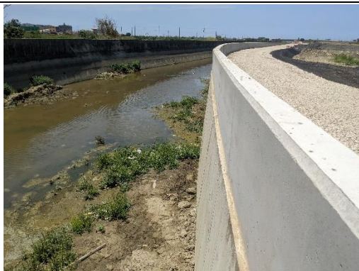
已完成護岸施作之區段 (拍攝日期 111.04.22)
