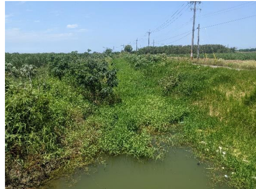
尚未施作段之現況 (拍攝日期 111.04.22)
