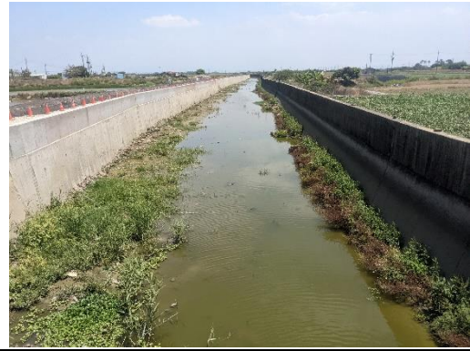
已完成之區段現況 (拍攝日期 111.04.22)
