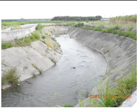
工區範圍內灣瀨區 (拍攝日期 110.11.4)
