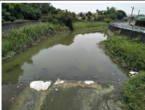
說明：上游排水路景觀
