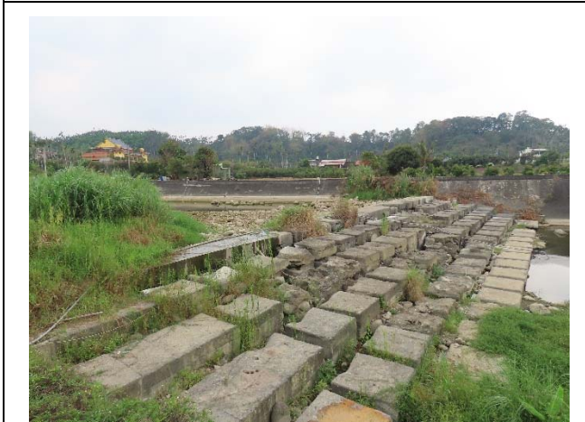
水岸及護坡照片
