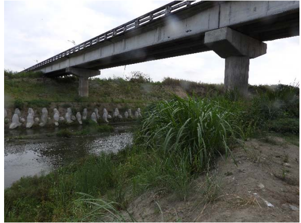
水岸及護坡照片
