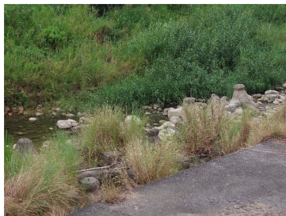
水岸及護坡照片
