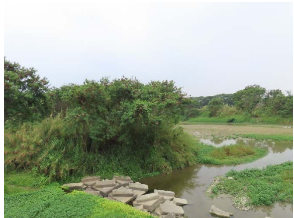
水岸及護坡照片
