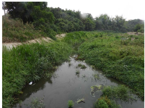
水岸及護坡照片
