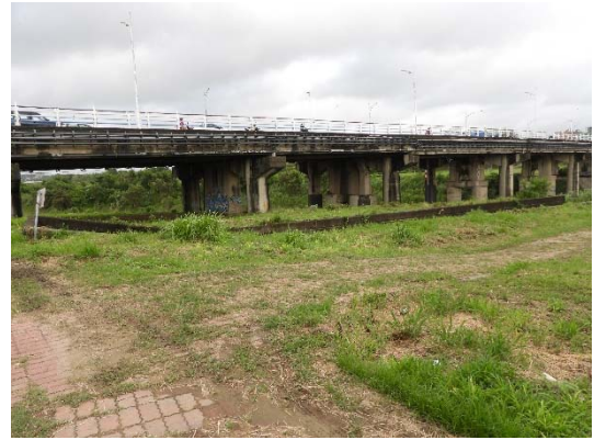
水岸及護坡照片
