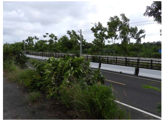
水岸及護坡照片
