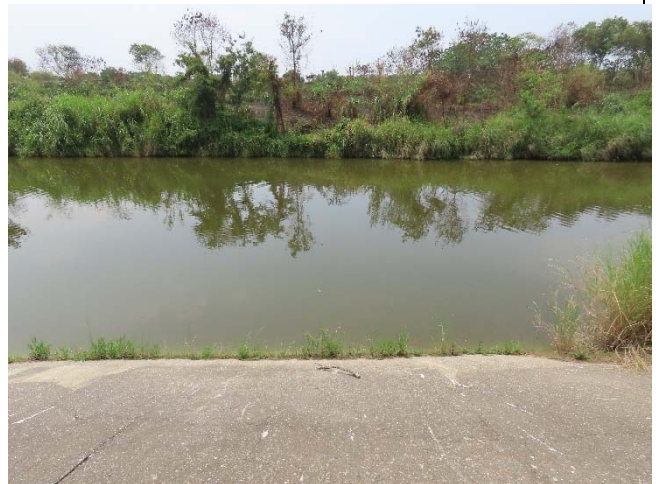
水岸及護坡照片
