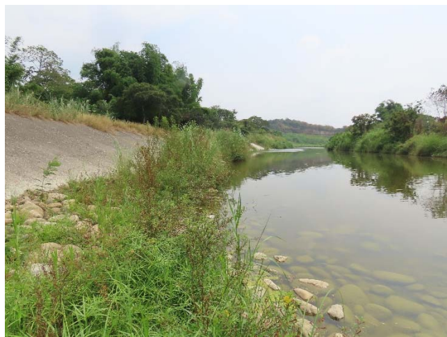
水岸及護坡照片
