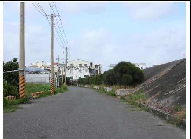
水岸及護坡照片
