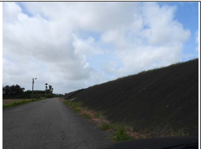
水岸及護坡照片
