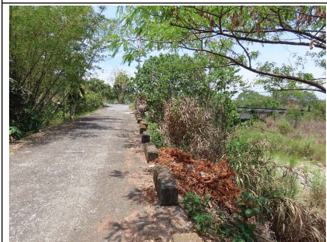
水岸及護坡照片
