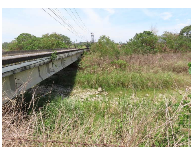
水岸及護坡照片
