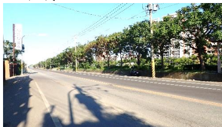
e. 安通路工區段
