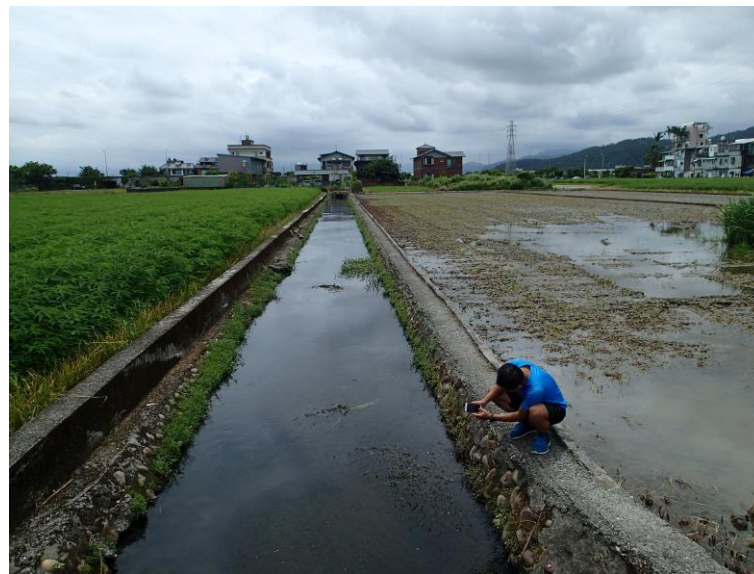
上游防潮閘門
