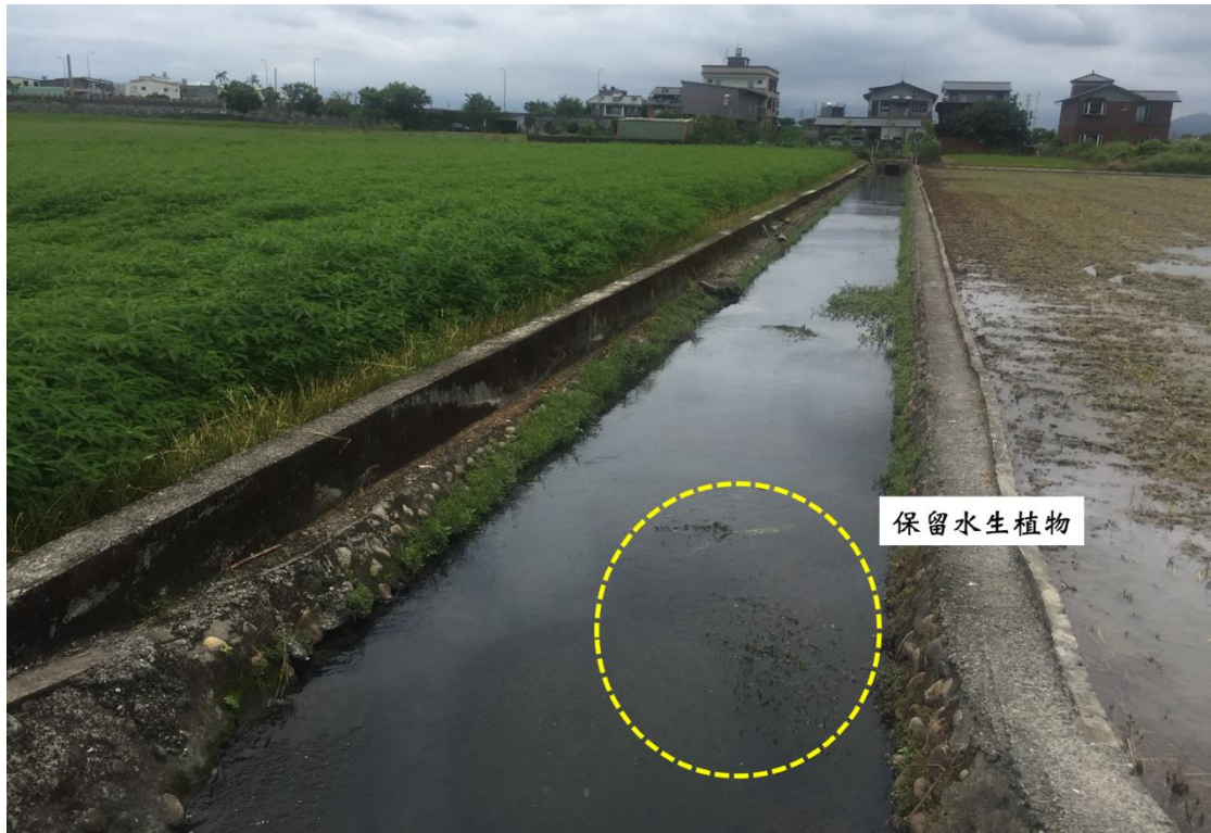
圖 3-2 七結排水保留底床水生植物之示意圖
