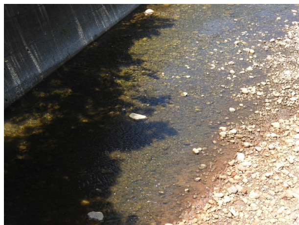
水岸及護坡照片
