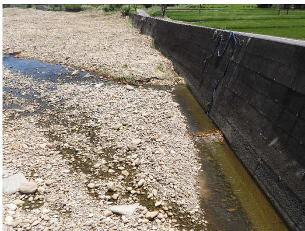
水岸及護坡照片
