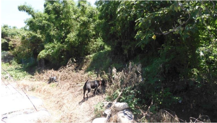
基地的土堤邊坡
