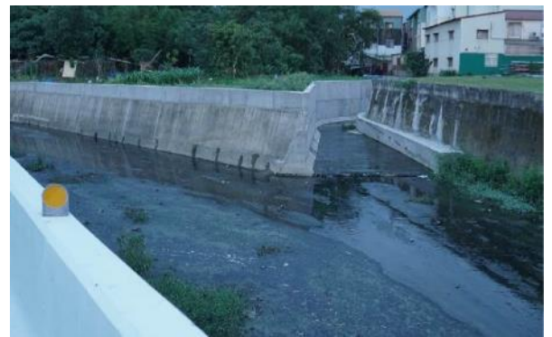
水岸及護坡照片
