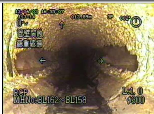
管壁破損
