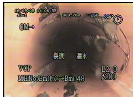
管壁破裂
