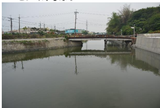
3. 工區下游河道狀況。
