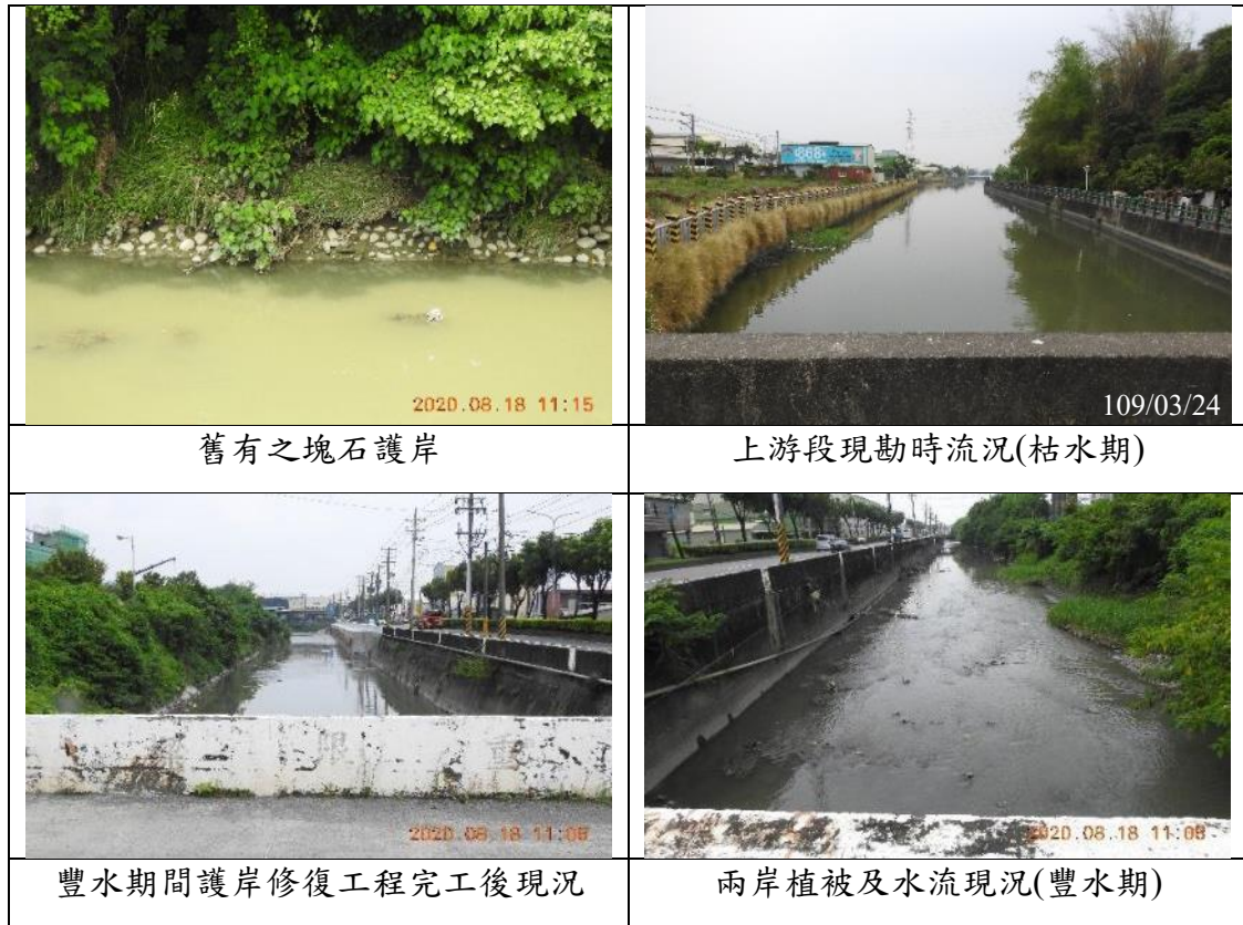
圖 4.11.1-2 「林園排水治理工程(10k+181~11K+300)(第三之二期)」與「林園排水左岸整治工程」預定工區施工前環境照
