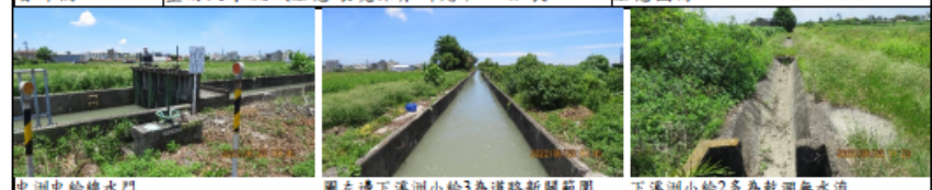
中洲中給線水門 圖左邊下溪洲小給3為道路新闢範圍 下溪洲小給2多為乾涸無水流
