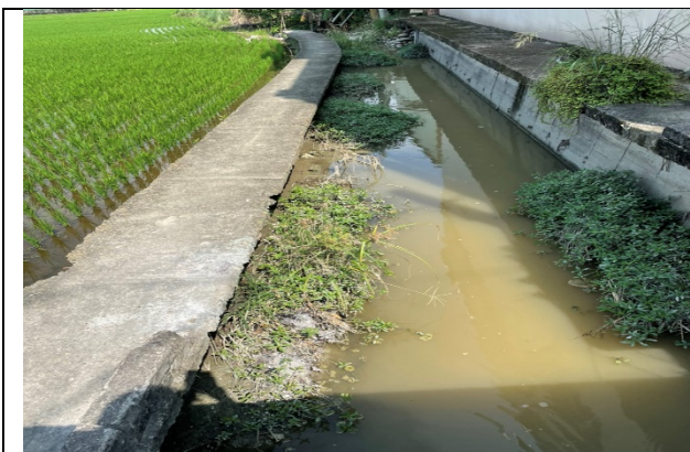
110/08/26 農田旁土堤排水路
