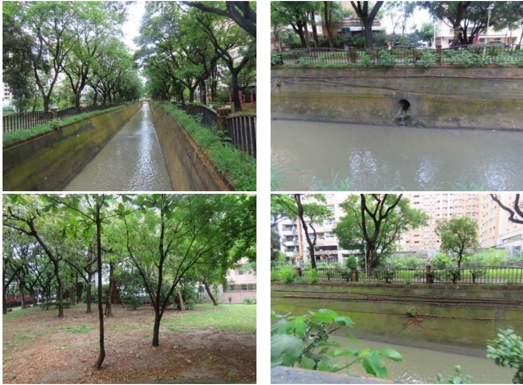
圖 4-2 右昌排水水環境營造工程現況環境照(111/05/10)
