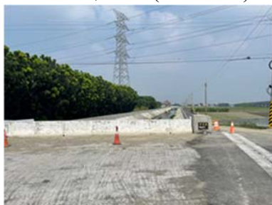
行卓橋工程現況(110.09.30)
