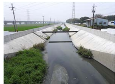
治理工程現況(111.03.16)
