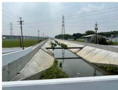
治理工程現況(110.09.30)
