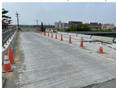
內寮橋工程現況(110.09.30)
