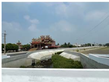
治理工程現況(110.09.30)
