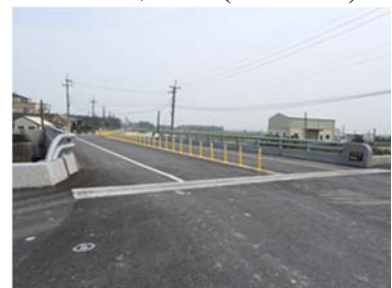
治理工程現況(111.03.16)
