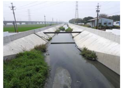
治理工程現況(111.03.16)
