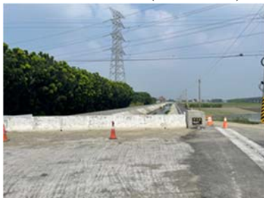
行卓橋工程現況(110.09.30)
