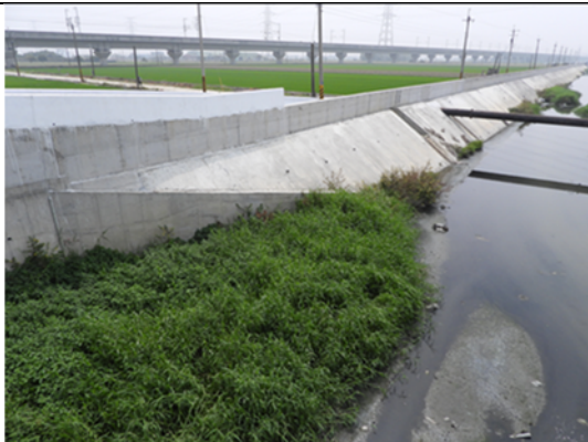
水岸及護坡照片
