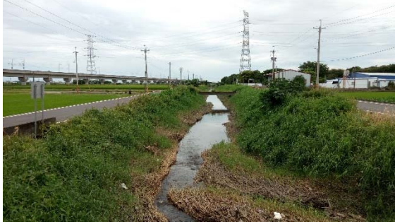
客子厝排水現況
