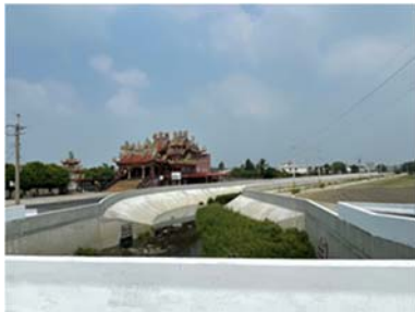
治理工程現況(110.09.30)
