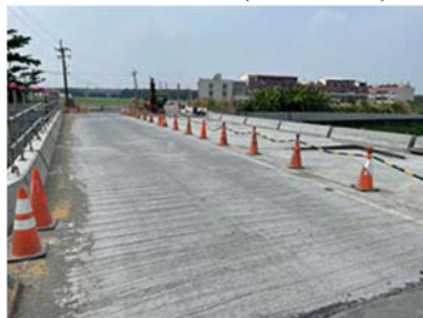
內寮橋工程現況(110.09.30)
