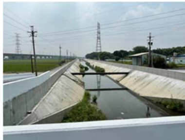
治理工程現況(110.09.30)
