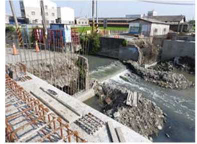
荷包嶼橋工程現況(111.04.08)
