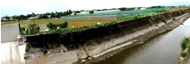
出口段新舊護岸銜接處
