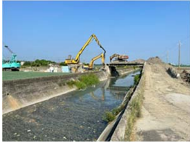
無名橋工程現況(110.10.04)
