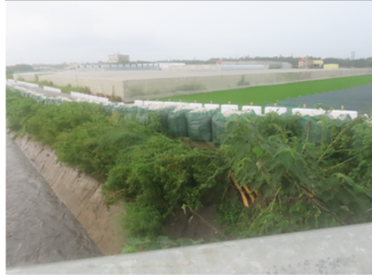
水岸及護坡照片
