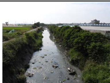
照片 2-1 棲地 1【施工前】 日期：111 年 04 月 08 日 位置：港後橋下游 概況：水流平緩 兩岸植被豐富
