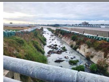
照片 2-3 棲地 1【完工後】 日期：112 年 12 月 04 日 位置：港後橋下游 概況：水流平緩 兩岸植被豐富
