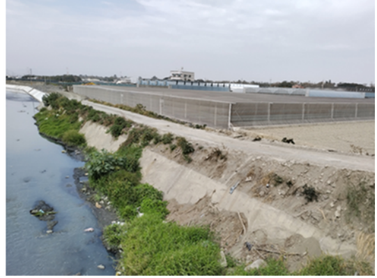
水岸及護坡照片
