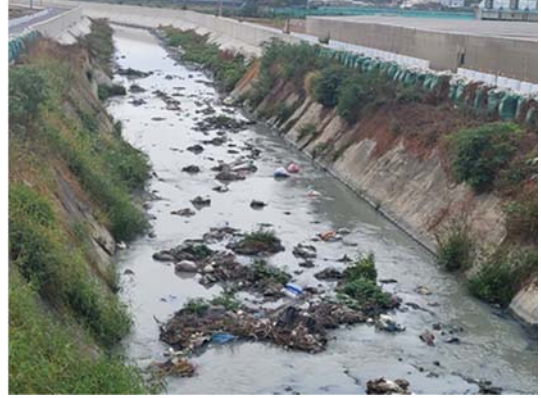
水岸及護坡照片
