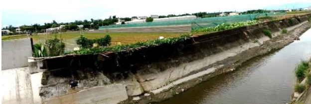
新舊護岸銜接處
