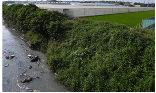
水岸及護坡照片
