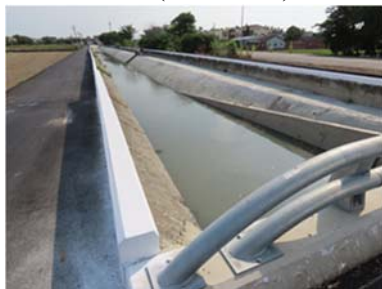
竣工後排水路(110.09.23)
