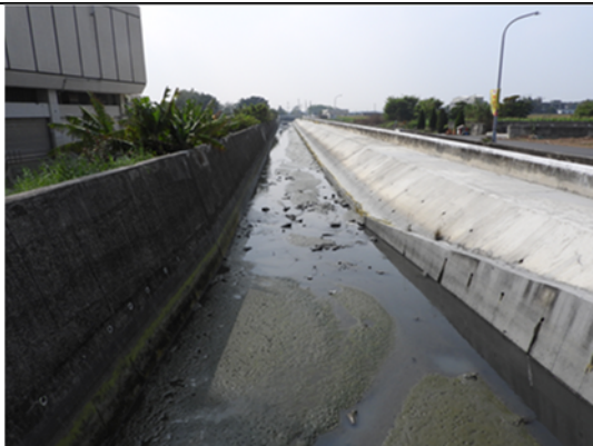
水岸及護坡照片
