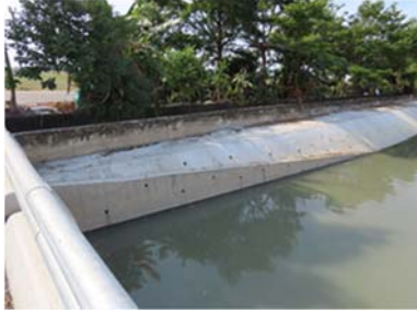
水岸及護坡照片
