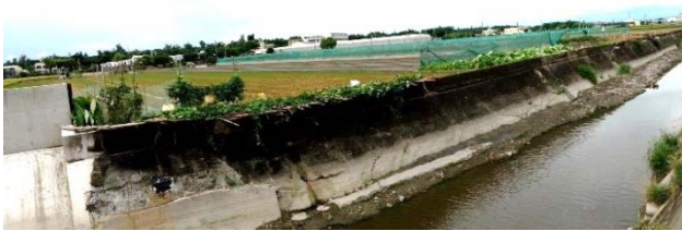
出口段新舊護岸銜接處
