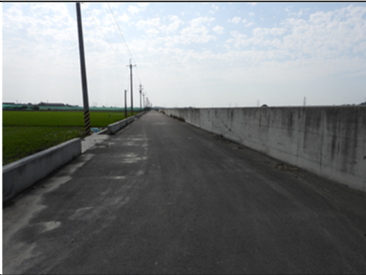
治理區水防道路現況
