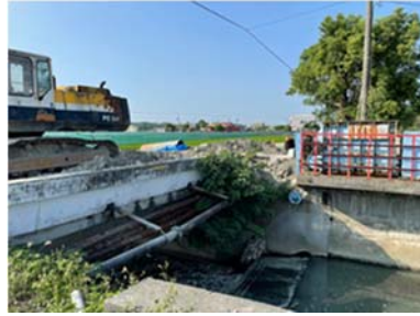
荷包嶼橋工程現況(110.10.04)
