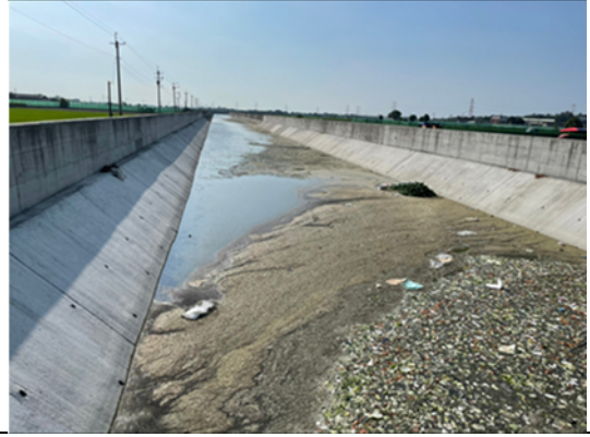
水岸及護坡照片
